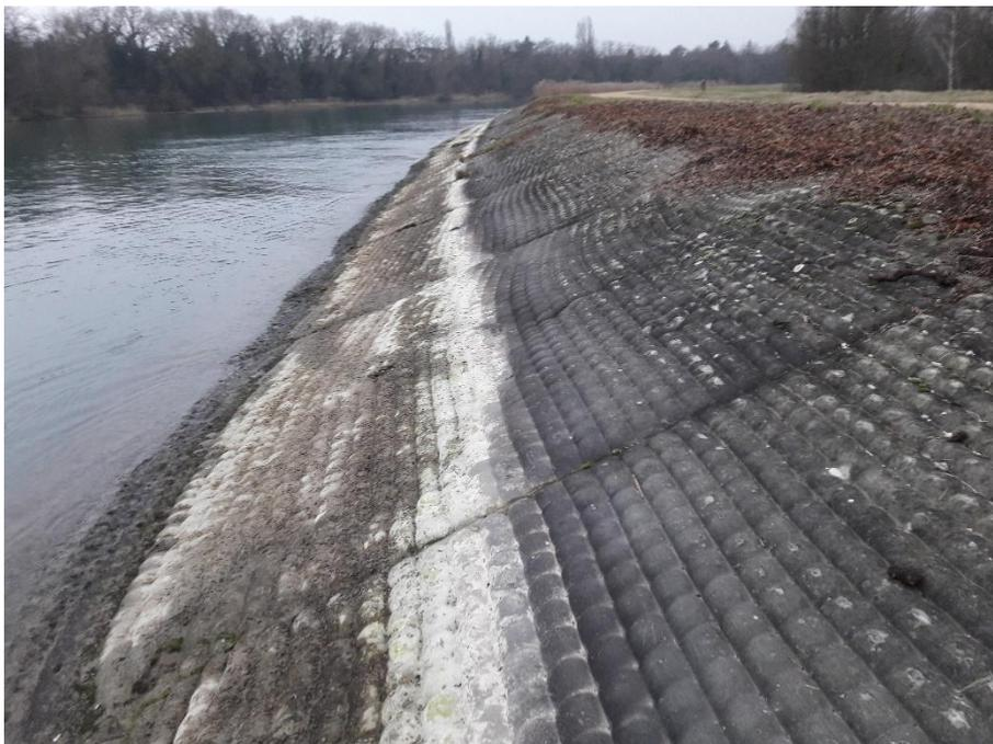
Figure 4. Exemple de Matelas Béton sur le talus installé en 1994 en rive droite du canal de Jonage.
