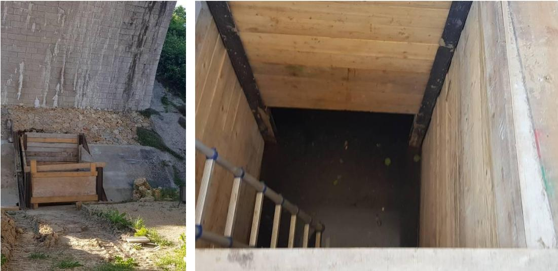
Figure 1. Blindage d'un puit d'accès en pied de culée
