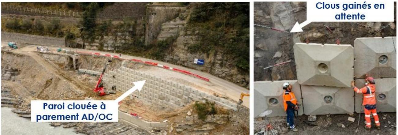
Figure 2. Chantier d'une brèche type dans la ROYA (Travaux en cours)
